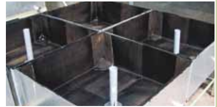
2. Vasche di prova impermeabilizzate
